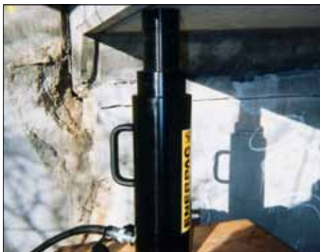
◀ O cilindro portátil com Porca Trava RACL-1506 utilizado como apoio prolongado para a carga, durante uma injeção de epóxi, para reforço de ponte.
